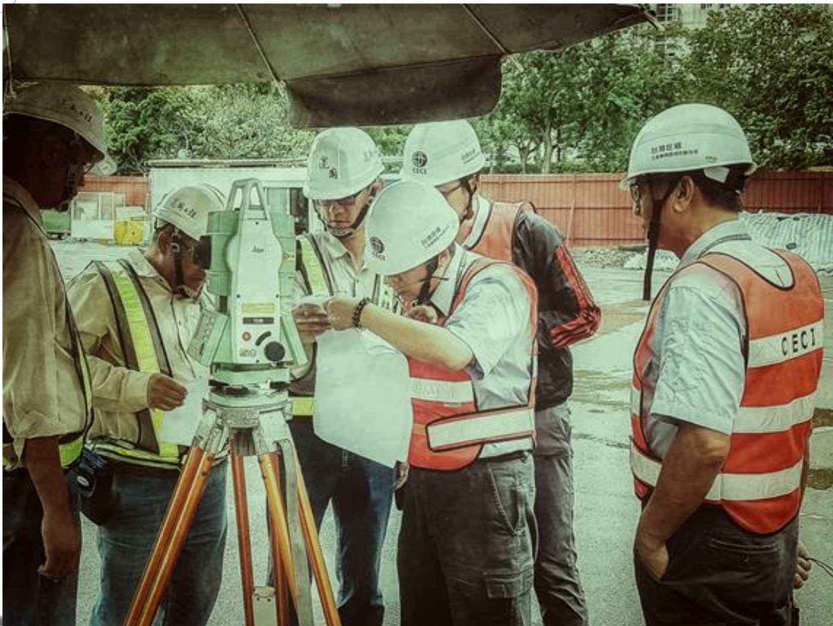
本工程為「台北市內湖區瑞光公共住宅統包工程」，拍攝內容係為工程最初，監造團隊與統包商於工區內進行基地測量放樣勘驗，以確保建築座落位置、範圍無誤。
