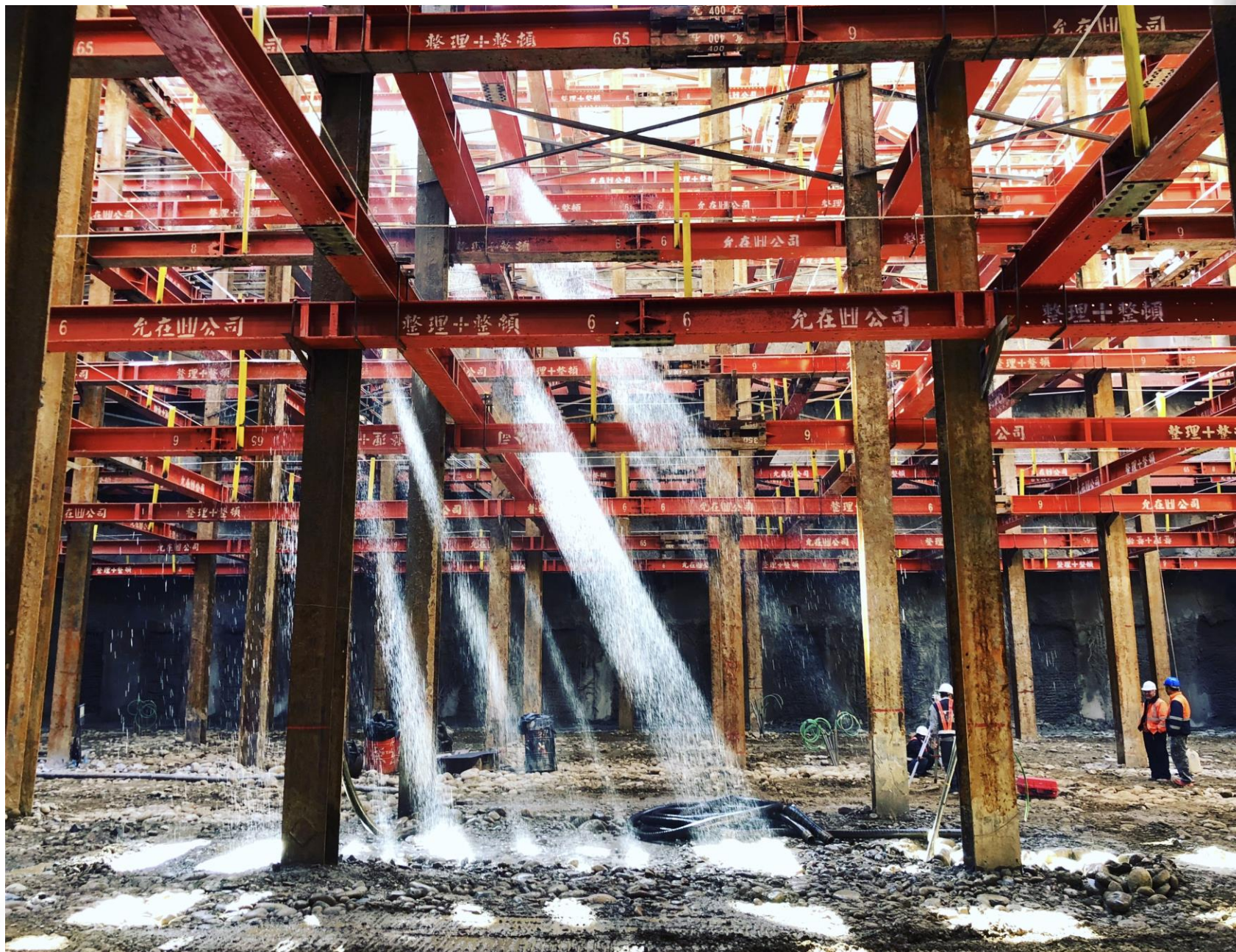
本處計畫「05130臺中捷運烏日文心北屯線出入口與土地開發場站共構工程施工期間技術服務及監造服務」，本照片攝於臺中捷運G05共構大樓之基地，覆工鈹上洗車的水落下與當日下午太陽的光，形成強烈的線條，為冰冷的工區注入溫暖柔和的光與影。
