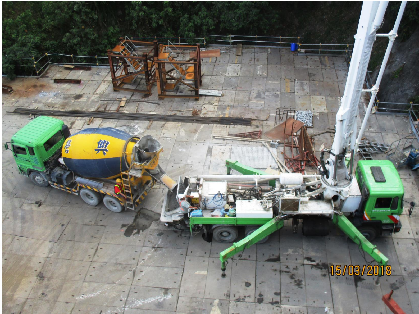
台九線南迴公路拓寬工程6號橋P4帽梁距離施工構台尚有約20M高差，澆置混凝土使用大型泵浦車，因為澆置現場各式施工機具噪音干擾，混凝土管尾與泵浦車間之無線電聯絡經常失效，管尾必須輔以手勢指揮，故泵浦車及預拌車司機須時時仰望墩柱頂端管尾的指揮。
