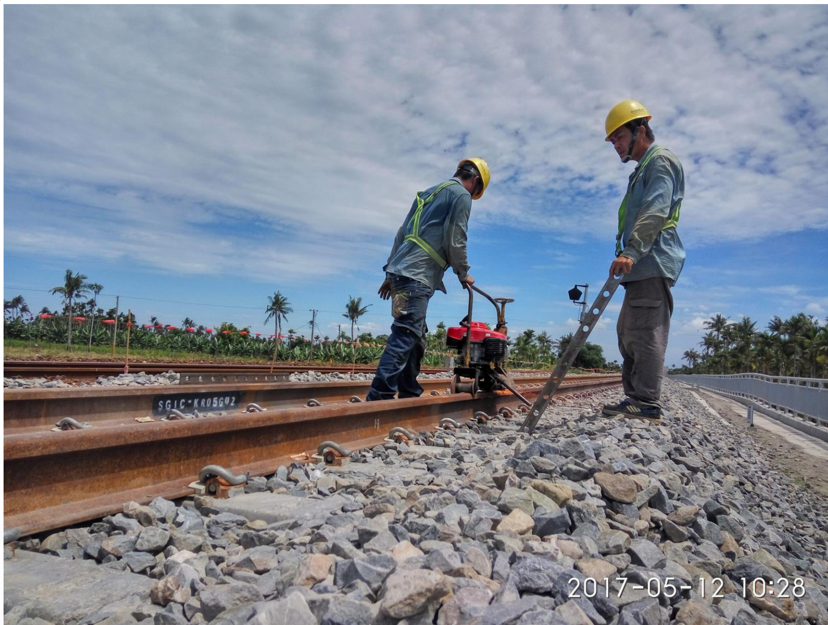
臺鐵南迴鐵路臺東潮州段電氣化工程建設C811Z標， 牛埔川橋北側道碴軌道鋪設完成長銲鋼軌道最終研磨檢視施工情形。
