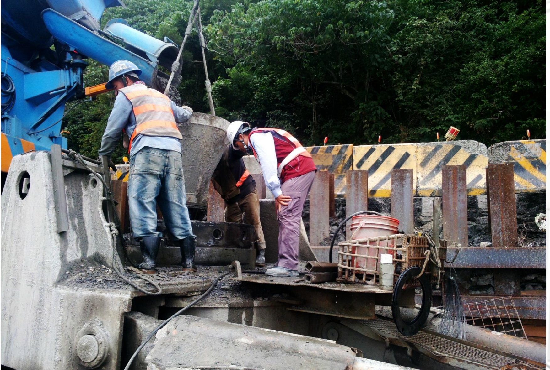
擋土牆全套管基樁澆置水中混凝土，於澆置過程中時刻查看深度及澆置情況，避免產生斷樁情事。
