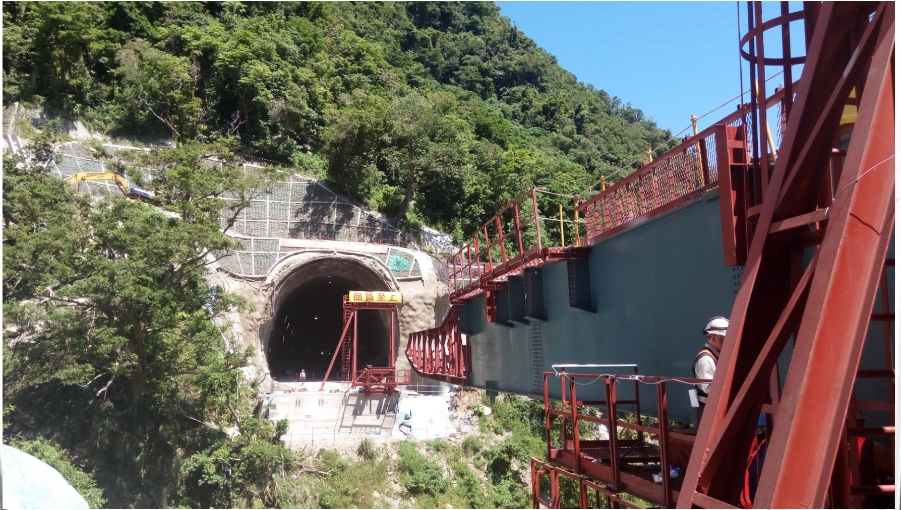
蘇花改工程是創造安全回家的路!而鼓音橋是串連觀音隧道和谷風隧道間的重要橋梁，鼓音橋也是全台首次嘗試以隧道組裝、推進施工的橋梁，在2017/06/28北上線首座支梁推出了!
