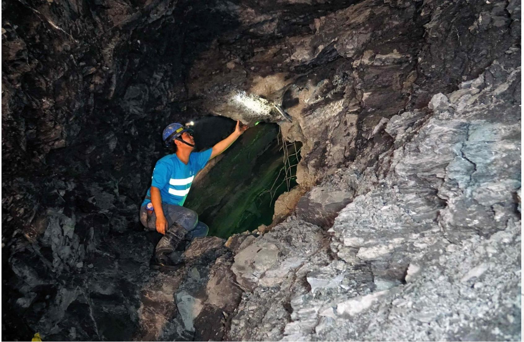
台9線安朔草埔段C2隧道標新建工程北上線全線，於107年3月22日上午05:00順利貫通。草埔隧道長度約4.7公里，位於東部變質岩區域，地質構造複雜，屬易湧水及受剪裂帶弱化等區域，為本改善計畫中最艱鉅的隧道工程，施工期間工程團隊遭遇多次施工困難，為減少複雜地質造成之阻礙，於施工過程中進行地質風險評估，並在遭遇潛在困難路段前即提出預警，使工程期間施工人員均能化險為夷，平安順遂。作品捕捉施工工班於貫通當下檢視開挖鏡面破口處，面露欣慰，百味雜陳之情境。
