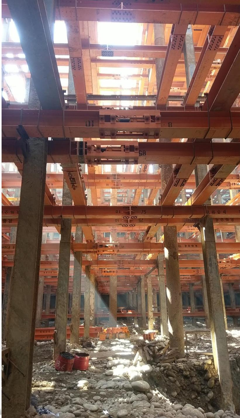
中捷聯開案G9-1站深開挖達36.75公尺，照片拍攝時為公區正進行第9階（最後一階）開挖，本工程擋土與排水施工困難度高，為目前臺中卵礫石層最深之深開挖案例。在底層仰望地面，冬天的溫暖日暉光線由各層支撐間灑落底層開挖面，在忙碌的工區中，不禁令人多駐留了一刻。
