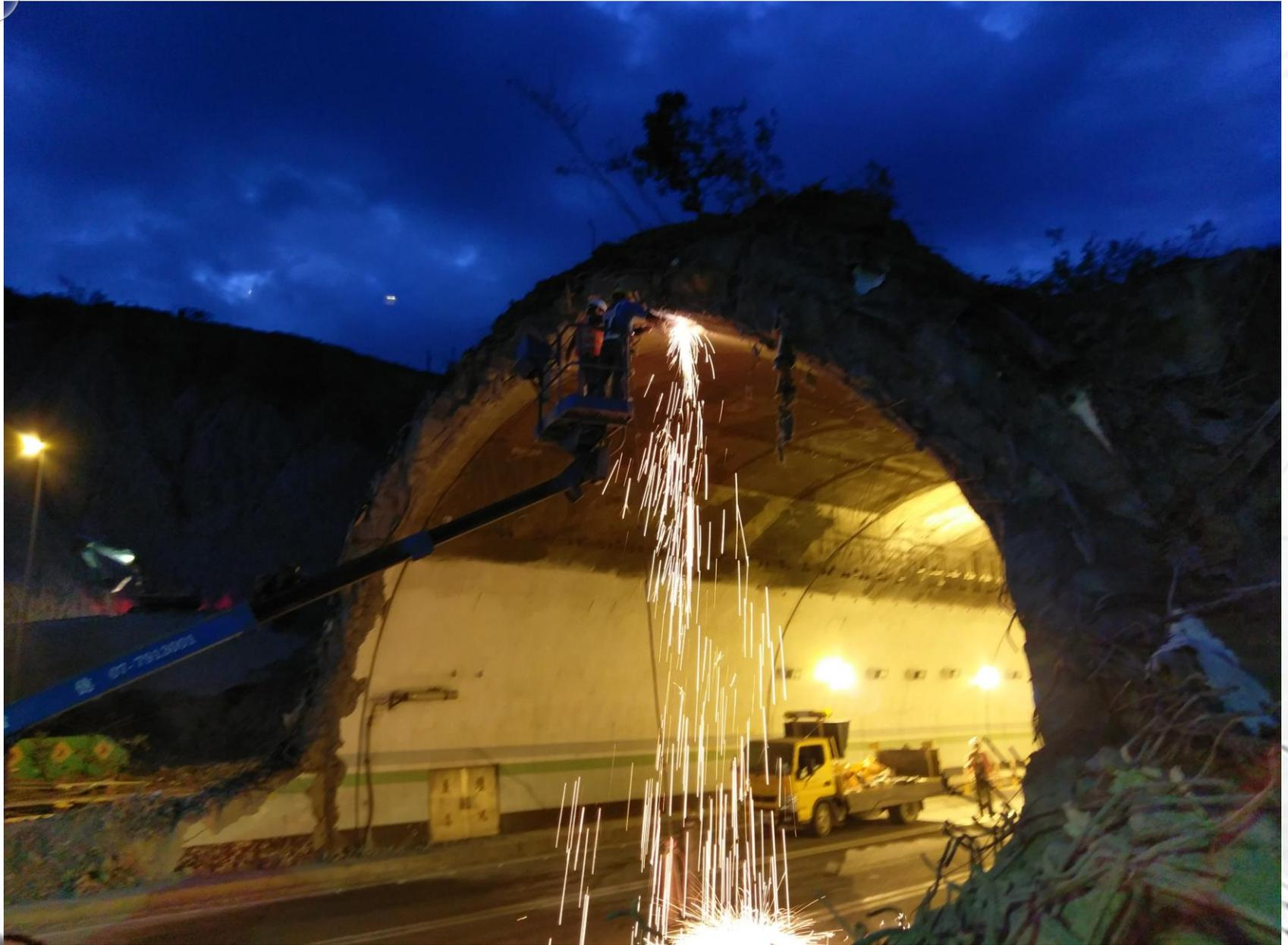
105公尺長隧道，要在13天完成拆除，且不能影響日間高速公路營運，故只能夜間施工，因此拆除過程必須小心謹慎，每個施工環節必須環環相扣，並且不能有不利影響營運安全之因素發生，以確保每日能準時安全開放通車。
