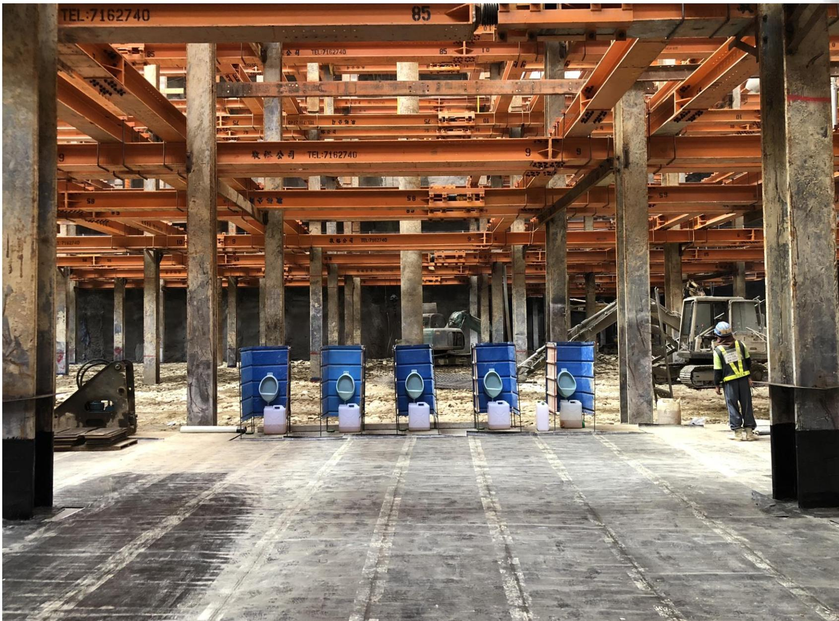
本公司承攬臺北市政府捷運工程局之「臺中捷運烏日文心北屯線出入口與土地開發場站共構工程(JJG051、JJG091標)」(含「IJXX07標臺中捷運烏日文心北屯線建設計畫G10站轉乘設施併水安公園地下停車場興建工程」)施工期間技術服務及監造服務，其中**G9-1共構出入口**開挖深度達37米，創下臺中深開挖紀錄，吸引各界單位、學者前來觀摩與交流。此照片為基地北側防水膜鋪貼完成後所拍攝，施工廠商於基地正中央擺放五具臨時小便斗供施工人員應急，小便斗與整齊的擋土支撐形成滑稽的對比。
