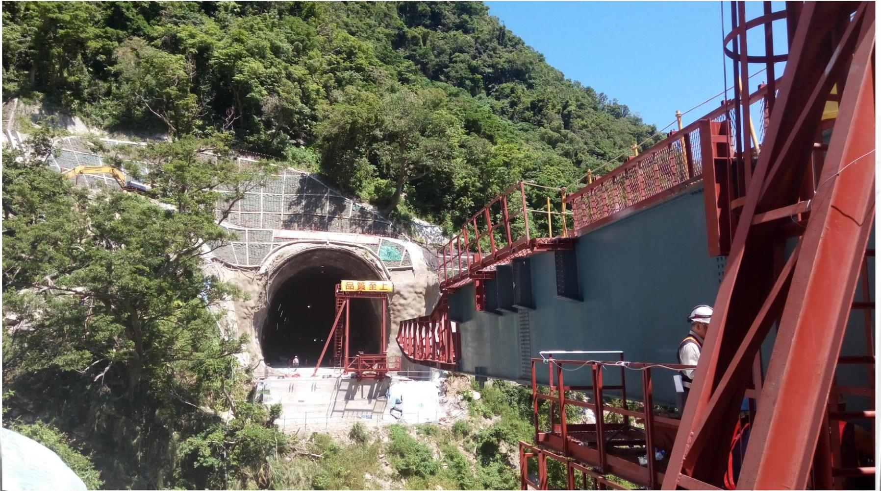
蘇花改工程是創造安全回家的路!而鼓音橋是串連觀音隧道和谷風隧道間的重要橋梁，鼓音橋也是全台首次嘗試以隧道組裝、推進施工的橋梁，在2017/06/28北上線首座支梁推出了!
